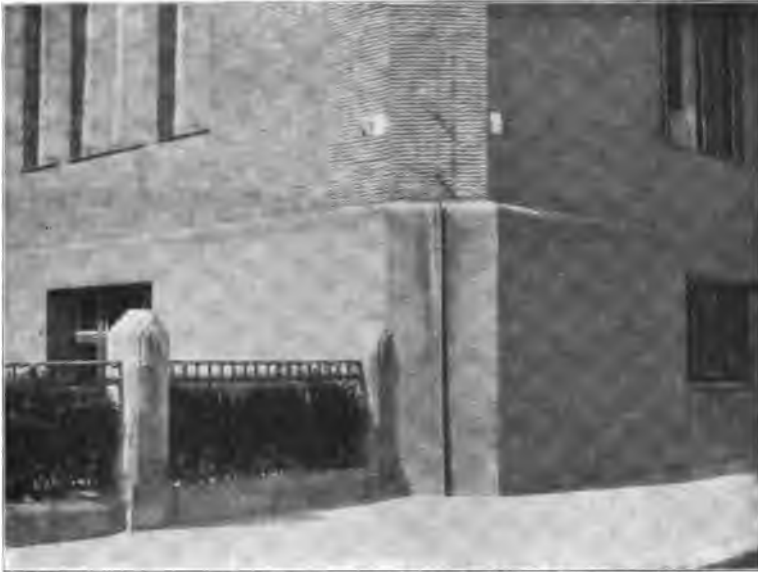
Abb. 130. Betonsockel eines Wohnhauses in München.
